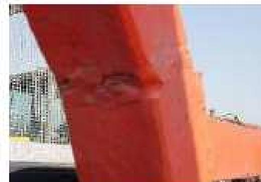
Fig. 8. Esempio di ammorbidimento di tubolare o sezione non circolare con depressioni della superficie che interessano anche gli spigoli e assottigliamento della sezione resistente utile
